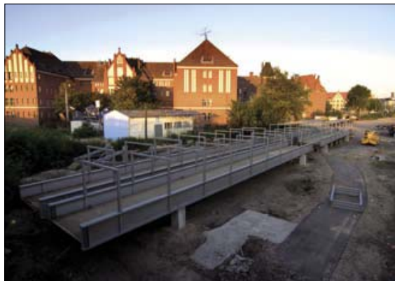
Auf den Vorortbahnsteigen mussten die Bahnsteigdächer weichen zugunsten der Ersatz-Fußgängerbrücke (rechts, noch nicht montiert)
