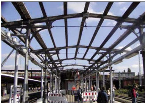
Auf den Vorortbahnsteigen mussten die Bahnsteigdächer weichen zugunsten der Ersatz-Fußgängerbrücke (rechts, noch nicht montiert)
